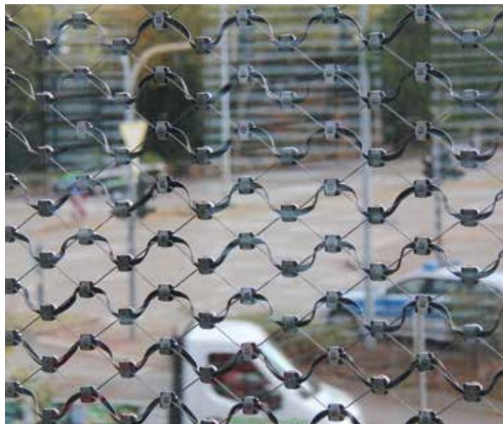
Das LED-Netz erreicht eine Transparenz von 65 bis 96%. Bei Installation vor einer Glasfassade dringt so noch genügend Tageslicht in das Gebäude und die Sicht nach draußen ist kaum eingeschränkt. Ein weiterer Vorteil: Das LED-Netz hat wenig Eigengewicht und bietet nur eine geringe Windangriffsfläche. Deshalb müssen auch nur geringe Lasten statisch berücksichtigt werden.
