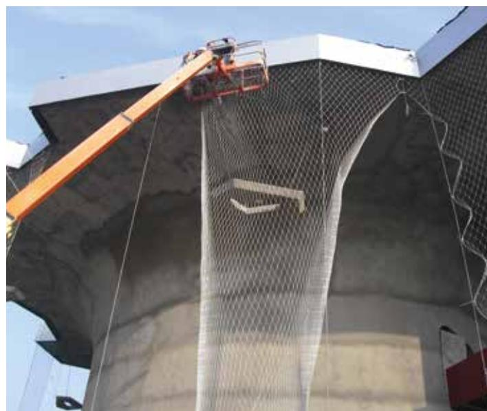
Die einzelnen Netzbahnen von X-LED Mesh können nahtlos zusammengefügt werden, es gibt keine Größeneinschränkungen. So sind große Spannweiten und Flächen ohne Zwischenbefestigung möglich. Das Edelstahlseilnetz wird nur umlaufend am Rand befestigt. Es hat eine hohe Festigkeit und besitzt eine Europäisch Technische Zulassung. Die einzelnen Systemkomponenten lassen sich einfach handhaben und sind schnell montiert.
